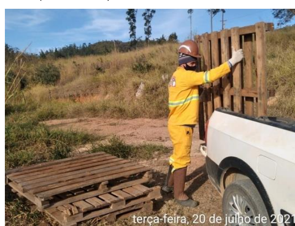
Foto 6 - Organização e limpeza na frente de serviço Data: (20/07/2021)
